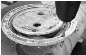
Fig. 1 – Limpeza da rosca danificada
