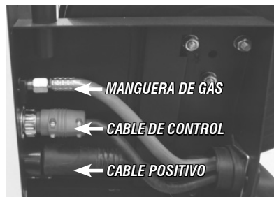
Fig. 4 - Conexión del conjunto de cables
