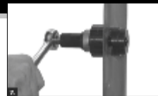
Fig.7 - Realizando o furo/Realizando el orificio
