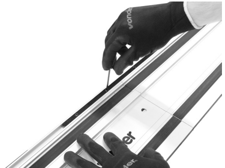
Fig. 18 – Fijando la unión de los rieles
