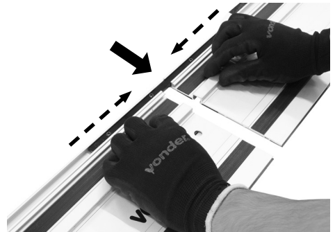
Fig. 17 – Instalando las barras de unión de los rieles
