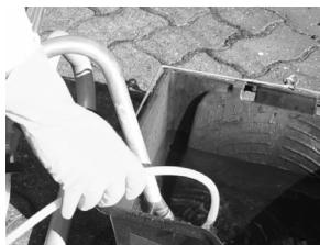
Fig. 9 – Preparando a máquina para pintura
