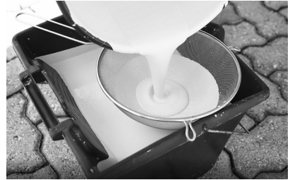
Fig. 14 – Coando a tinta
