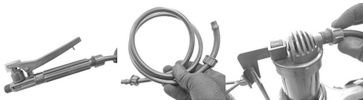
Fig. 8 – Instalación de la manguera
