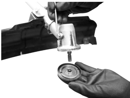
Fig. 6 – Montaje de la breda interna
