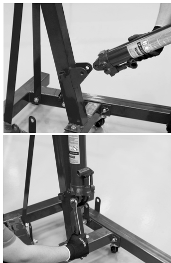
Fig. 7 – Montagem do sistema hidráulico
